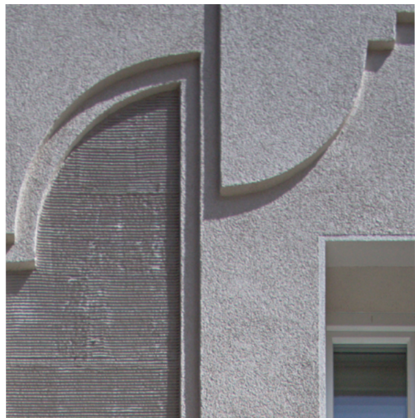
Bei dieser Fassade mit WDVS wurden aufwändig Putzornamente aufgebracht.
