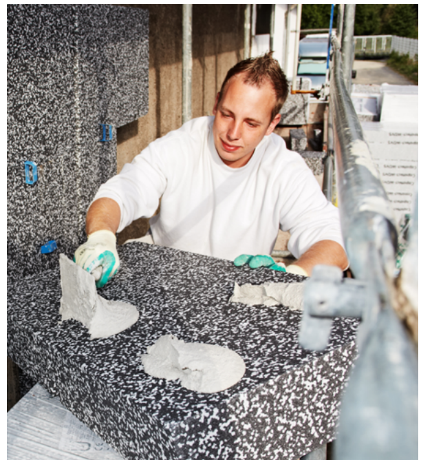
Anbringung einer Polystyrolplatte.
