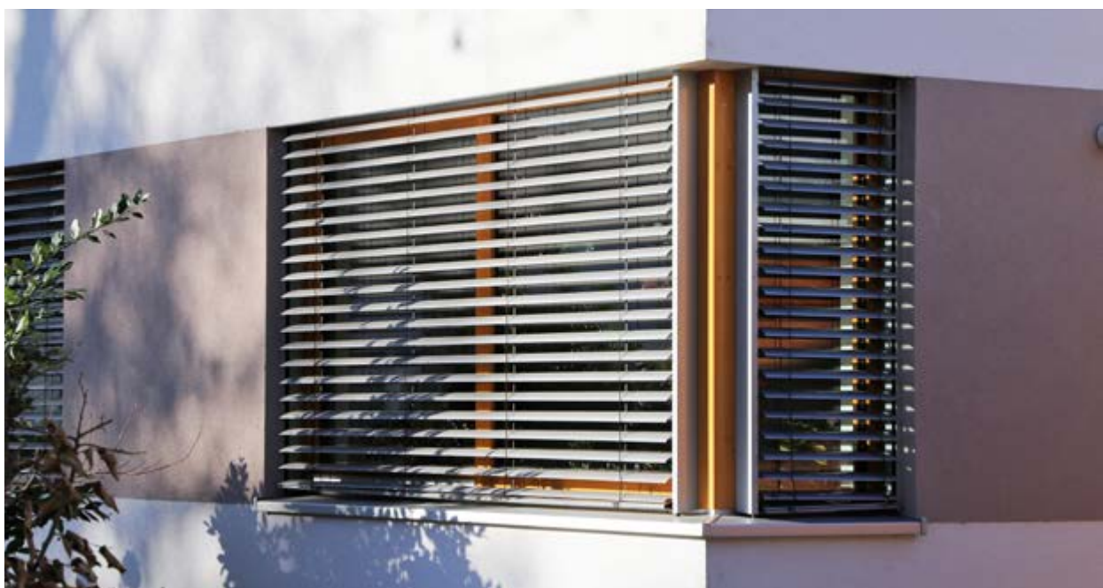
Raffstores als außen angebrachter Sonnenschutz.
