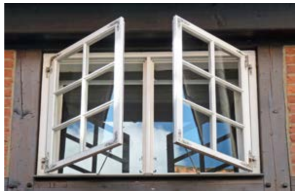
Historisches Fenster mit zusätzlichem Innenvorfenster.
