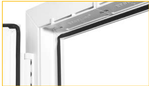
Fensterfalzlüfter ermöglichen einen permanenten Luftaustausch.
