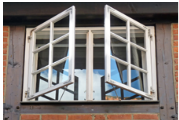
Historisches Fenster mit zusätzlichem Innenvorfenster.
