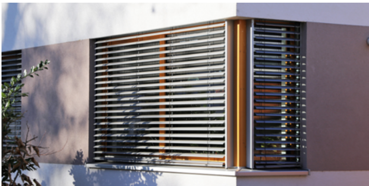
Raffstores als außen angebrachter Sonnenschutz.
